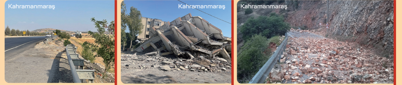
Deforme olmuş yol
